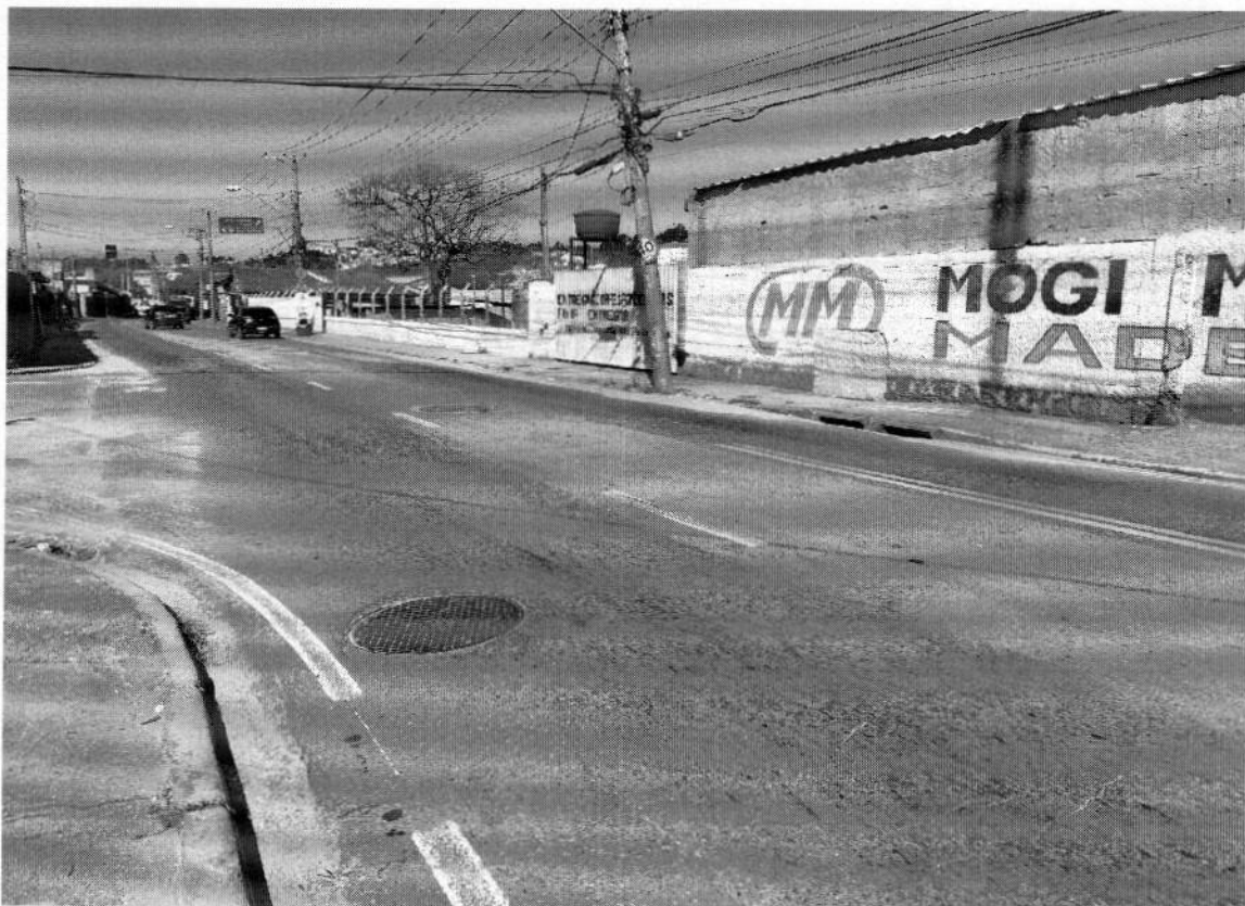
IMPLANTAÇÃO DE REDUTOR DE VELOCIDADE DO TIPO LOMBADA NA AV PREF. CARLOS ALBERTO LOPES EM FRENTE AO Nº789, MOGI MODERNO – MOGI DAS CRUZES.
